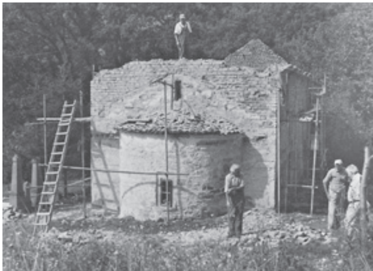
Сл. 5. Поглед на цркву са истока (септембар 1997), Завод за заштиту споменика културе у Нишу
